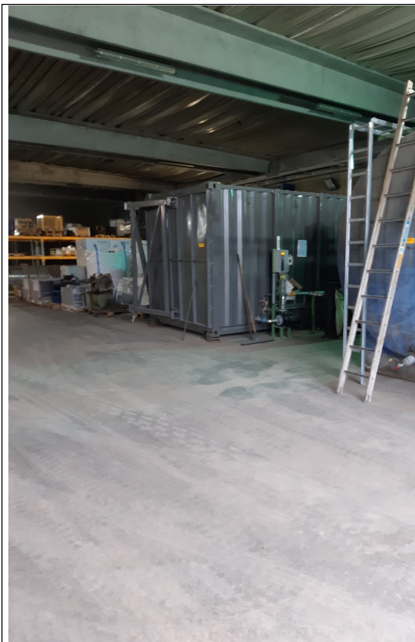
Container med rensning af overfladevand til genbrug i produktionen
