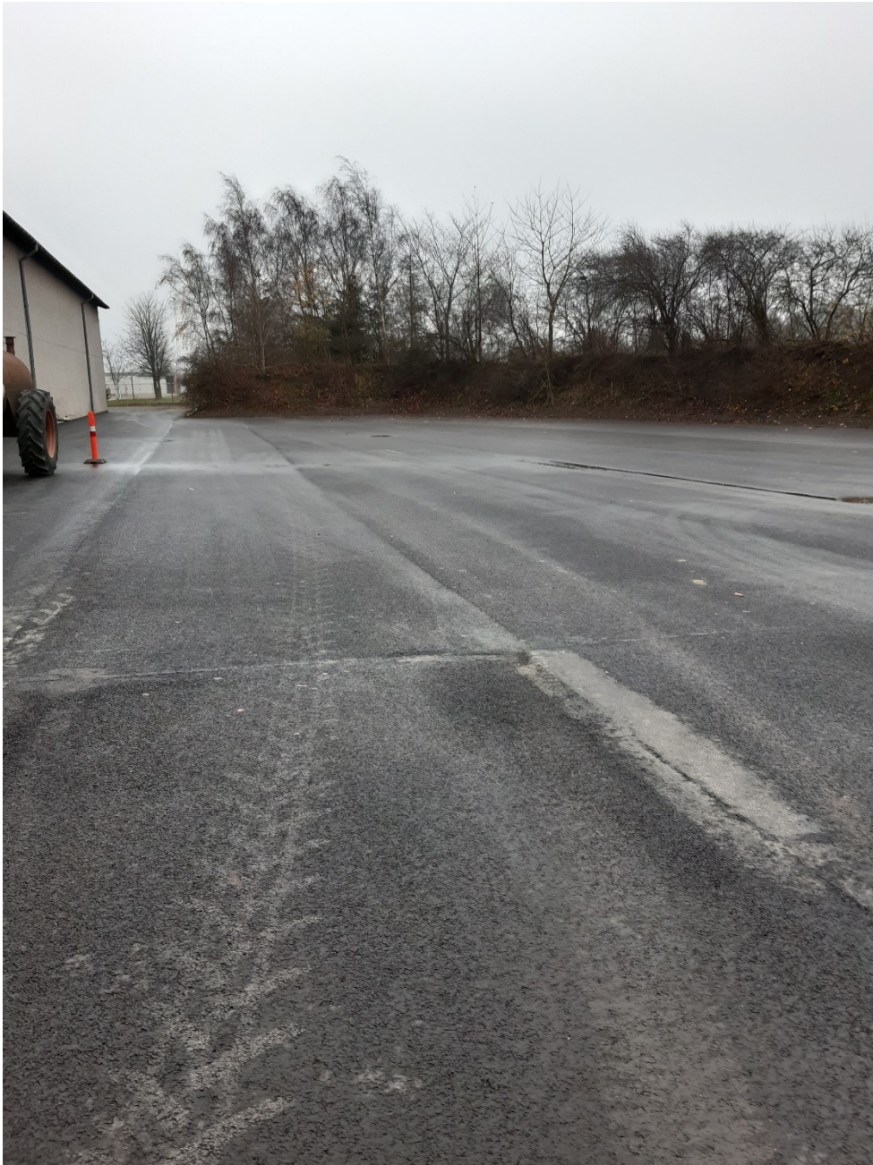
Nyt befæstet areal mod syd.
