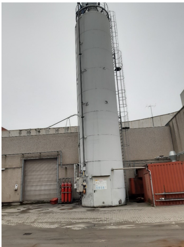
Silo med kulstøv bliver taget ud af drift ved overgang til gas.
