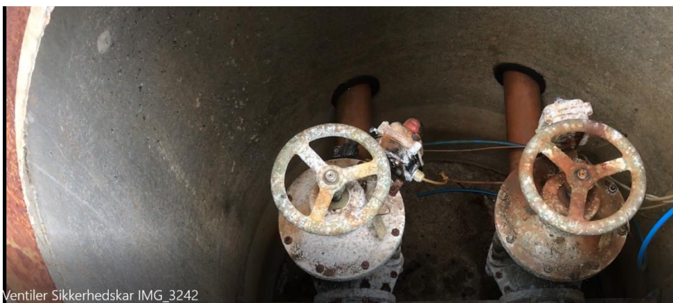
Stilbillede; lukkede ventiler, da høj ledningsevne grundet vejsaltet registreres i følerne.
