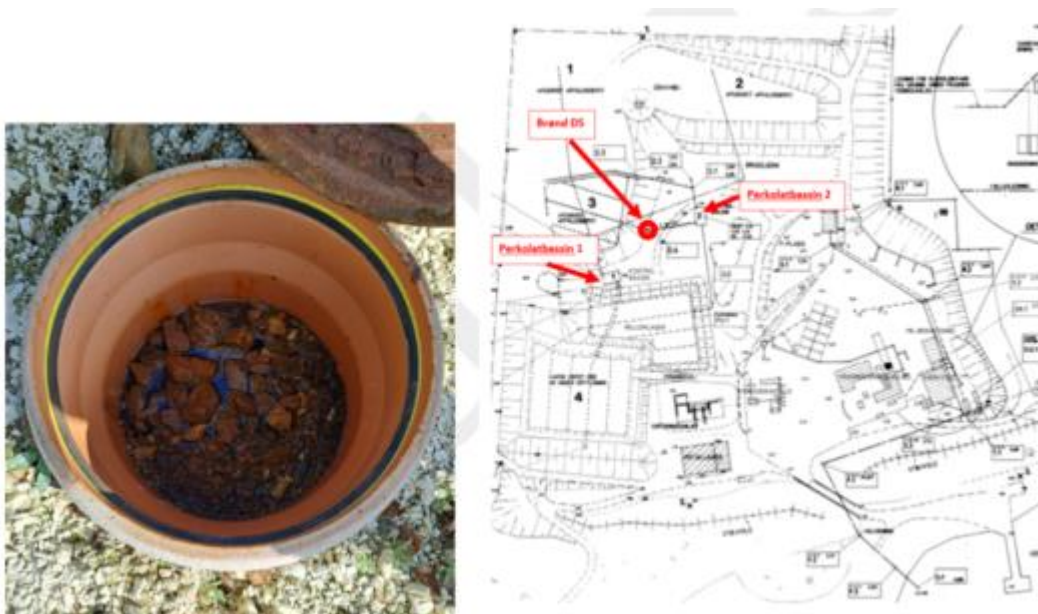
Billede 5. Perkolatbrønd D5 med affaldsskum og opstuvning. Kortet viser placeringen af brønd D5, perkolatbassin 1 og 2.
