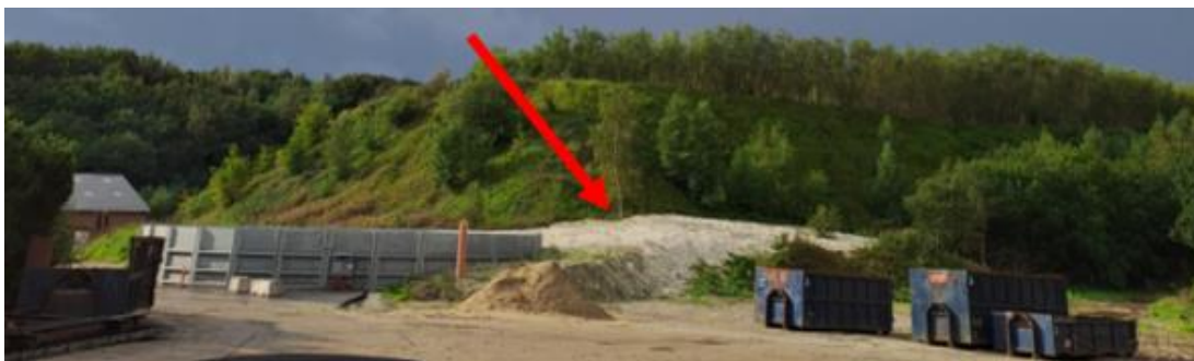
Billede 4. Overskudsjord fra etablering af bundfældningstank genplaceret delvist op ad skrænten på deponiet.
