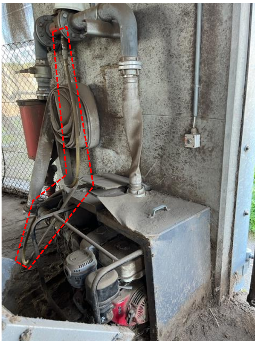
Foto 3: Pumpe, dysesystem og ejektor inde i træflissioloen. Plastslange og metalstuds til at putte i dunk med slukningsmiddel er markeret med rød stiptet kontur.
