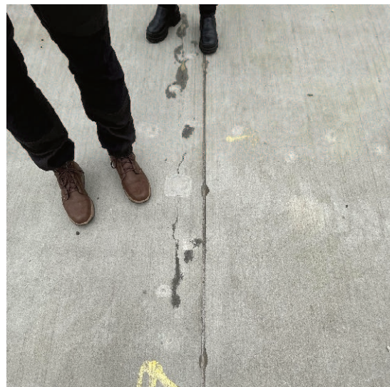
Reparationer i tankgårdsbund
