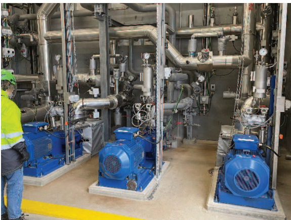
Pumperum, tre motorer til læsserampe
