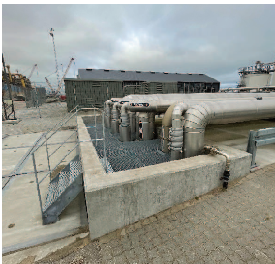
Påkørselssikring af rørledninger
