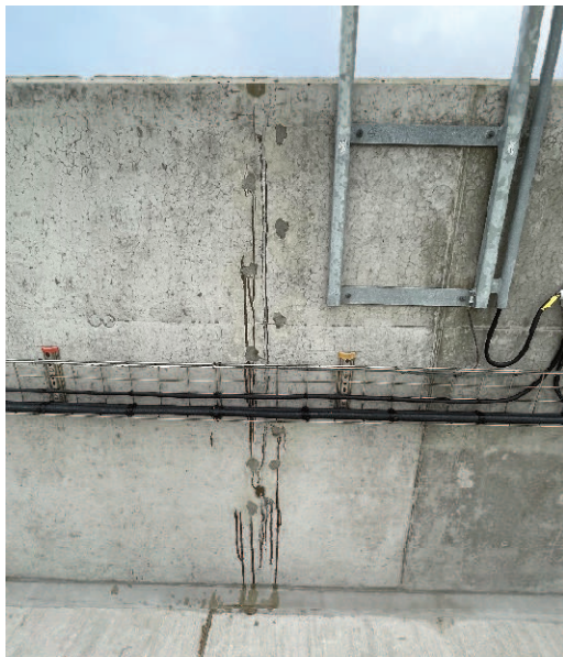
Reparationer i tankgårdsmur
