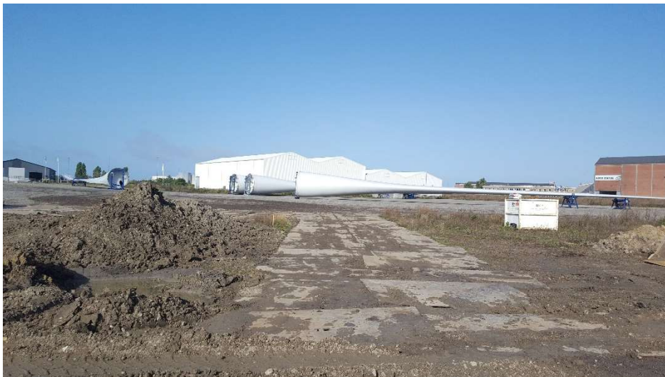
Foto: manglende afspærring på nordlig del af pladsen.
