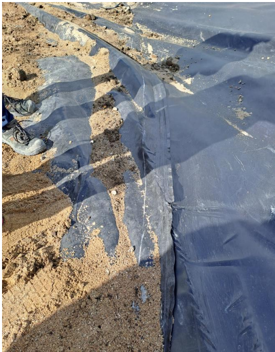
Billede 4. Sammensvejsning af ny og gammel membran (1C).
