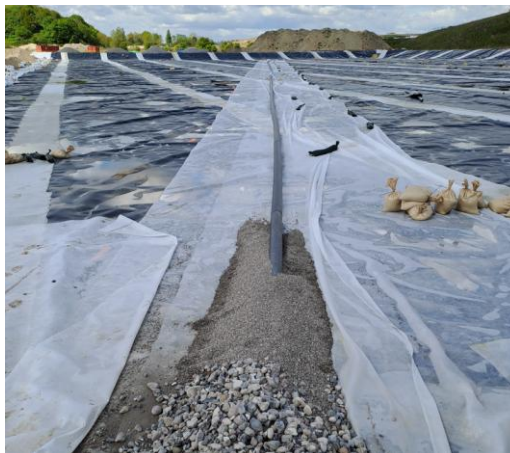
Billed 3. Udlægning af hoveddræn. De hvide striber på polymermembranen er bentonitmåtter, der er lagt ovenpå samlingerne.
