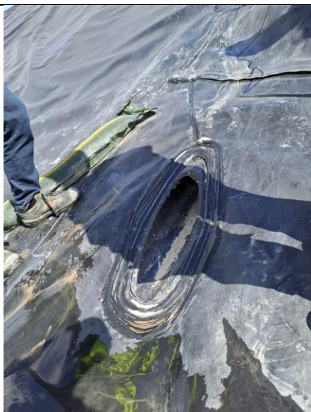
Billed 6. Udløbsbygværket på sydlige del af enheden, hvor hoveddrænet for perkolat er ført gennem voldanlægget.
