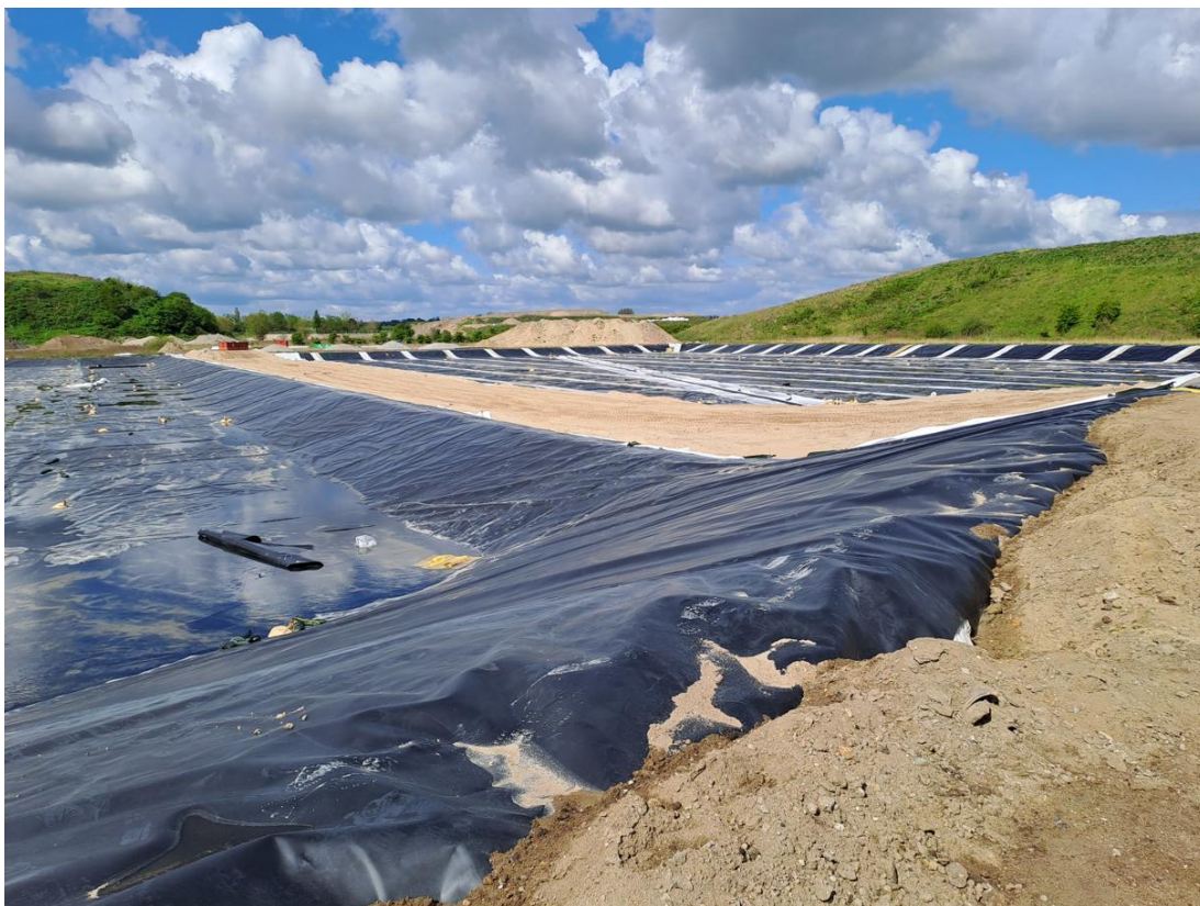
Billede 1. Udlægning af drængrus og dræn på den nordlige del af enhed 3A. Der stod meget vand på membranen, da det havde regnet om natten.
