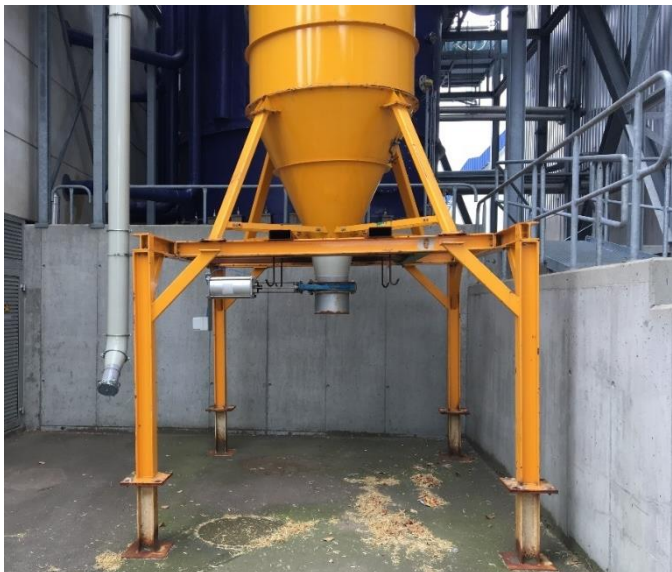
Figur 2-4 Stativ til ophæng af big bags inden tømning af fyldlegemer fra røggasrensning
