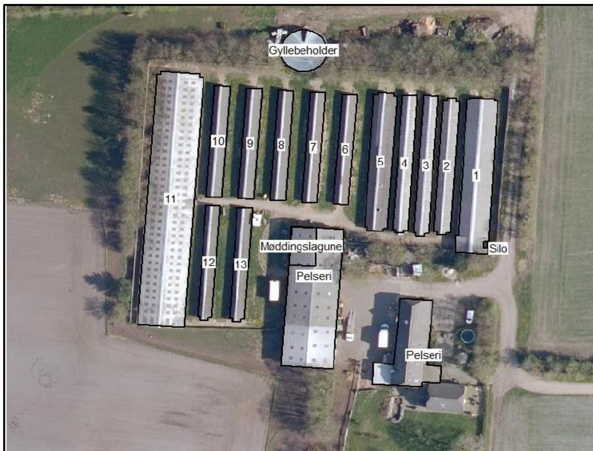
Figur 3. Oversigt over husdyrbrugets bygninger.
