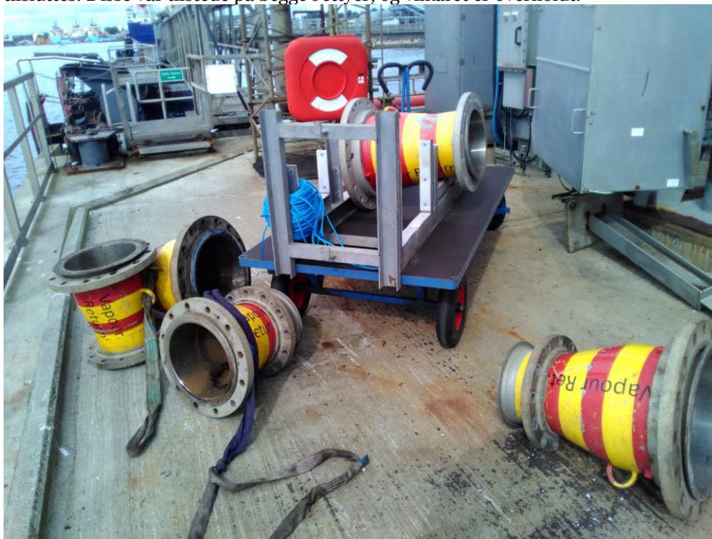
Foto 4: 5 stk. reduktionskoblinger på Jetty 2.
