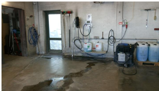
Billede 1 – oplag af sæbe uden spildbakke i garage med afløb
