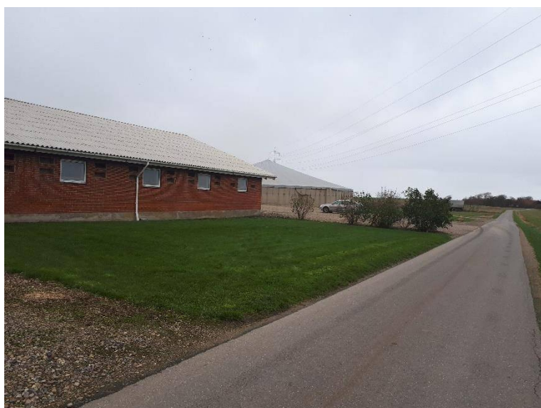
Fra Dalagervej. Billedet viser den staldbygning, der skal forlænges med ca. 10 meter mod nord.
