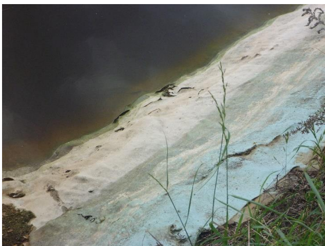
Fig. 4 Revner i perkolatbassinets membran
