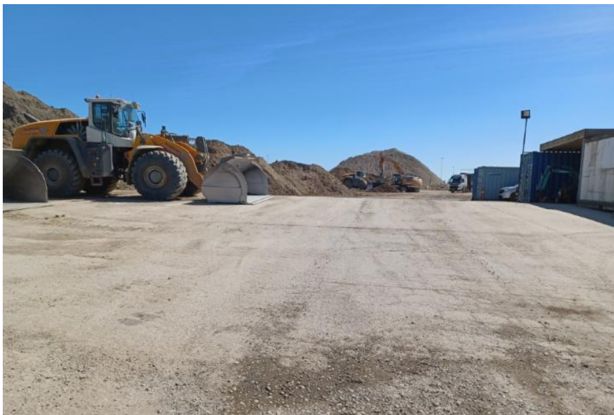
Billed 2. HCS oplagsplads for jord på ikke slutaftdækket areal på E1C.
