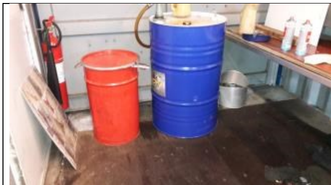
Tønde med olie i container med gasanlæg.
