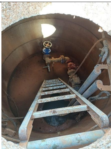
Deponi III. Kig ned i pumpebrønd G, der var lav vandstand og derfor ingen pumpning
