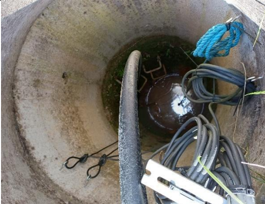
Deponi III. Kig ned i drænbrønd
