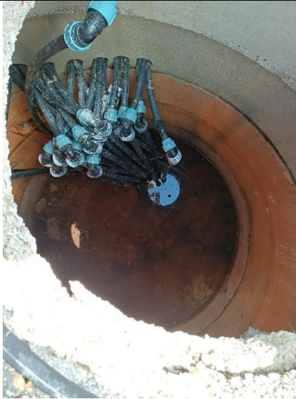
Deponi III. Kig ned i gennemløbsbrønd inden pumpen, det er herfra kondensvandet fra biocover tilledes perkolatet.
