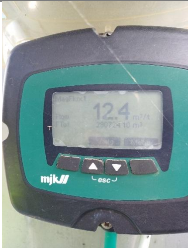
Deponi III. Pumpen i pumpebrønden blev igangsat og der sås flow.
