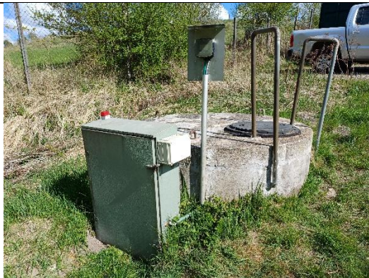
Deponi III. Pumpebrønd G til perkolat op til gravitationsledningen starter i den nord østlige del af III.
