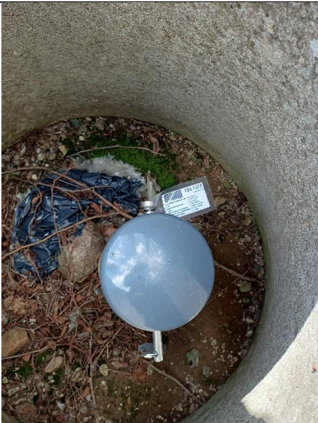
Deponi III. Boring GKB4 med mærkat med DGU nummer.
