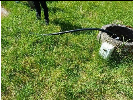
Deponi III. Drænbrønd fra dræn under bassinet. Drænbrønd fra dræn under bassinet. Vandet tilledes i overjordisk slange til bassinet.
