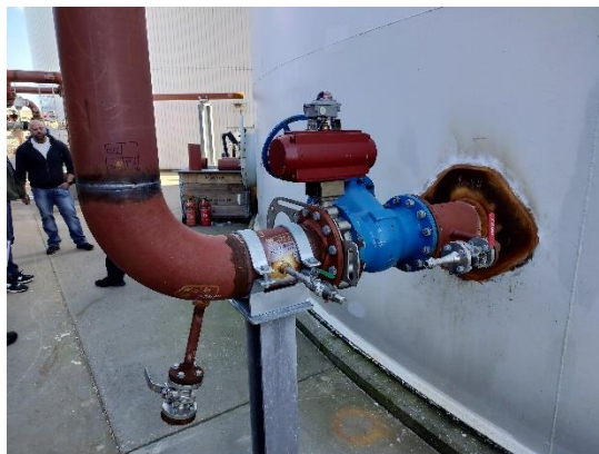
Rørføringer, ventiler mm. til læsserampe under etablering.
