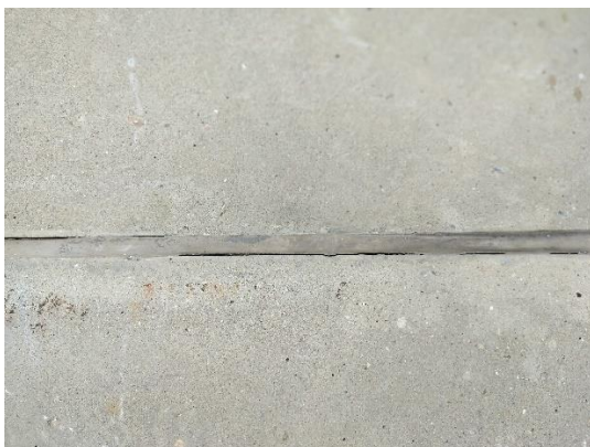
Fuger i tankgård, der muligvis ikke er 100% tætte. Det aftales på tilsynet, at disse udbedres.
