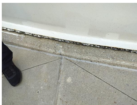
Fuger i tankgård, der muligvis ikke er 100% tætte. Det aftales på tilsynet, at disse udbedres.
