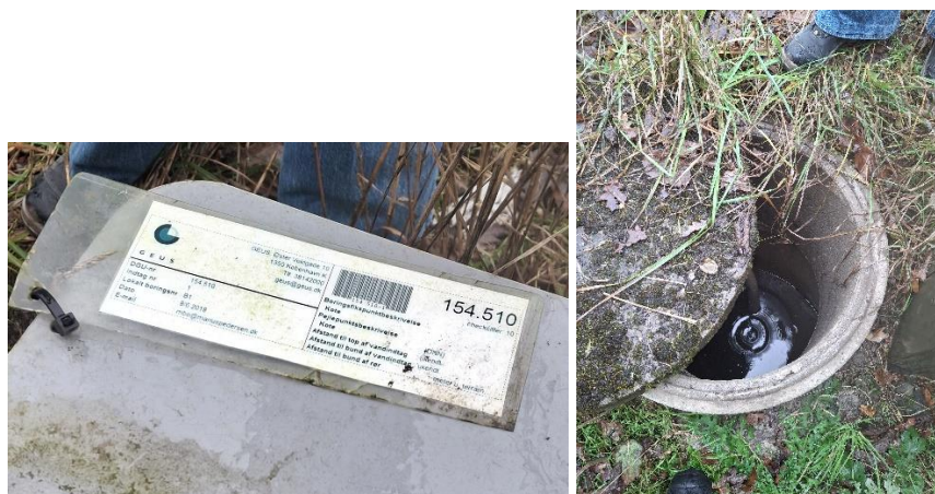
Figur 6. Grundvandsmoniteringsboring B1 ved tilsynet
