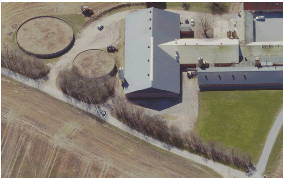
Figur 3. De 3 køreveje ind til ejendommen Holtbjergvej 38.
