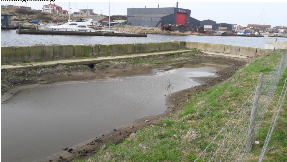
Figur 7. Hvide Sande Havn. For-bassin til losning af sediment fra skib, inden det køres i dumper til de aktive etaper.
