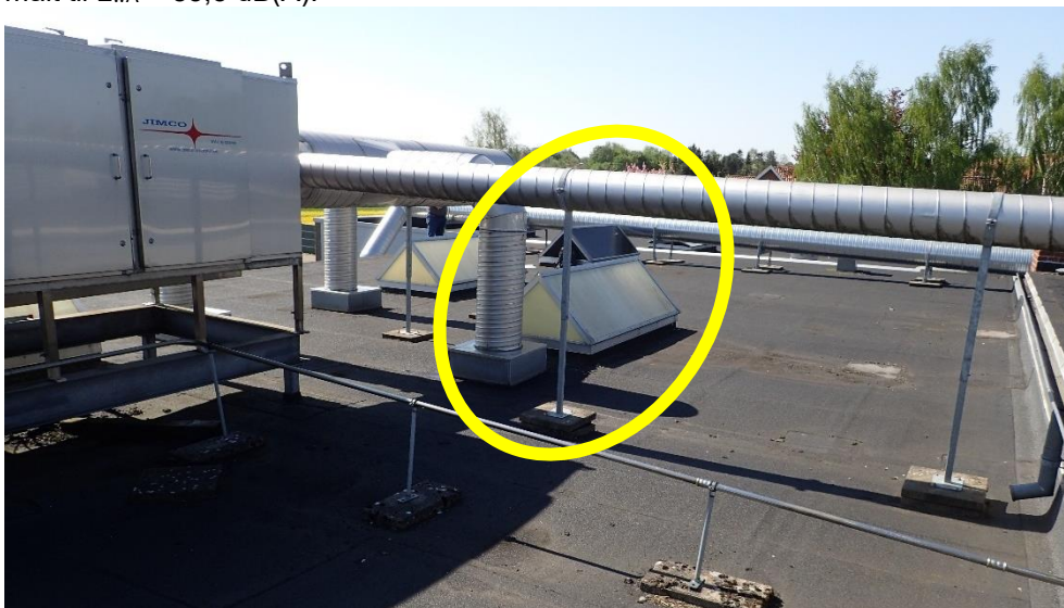
Figur 7. Støjkilde 100 – ovenlys over plukkerrum.
