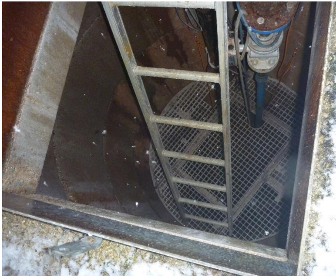
Foto 1: Perkolatbrønd P1 fremstod ved tilsynet med styreskab, brønd og dæksel i god stand.
