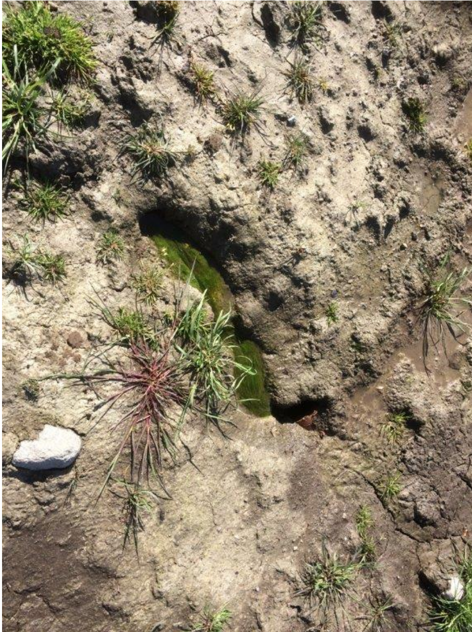
Figur 5 sø 2, dræn i bunden af søen er gået i stykker, en smule af drænet ses på billedet. Der var lidt vandstrømning i den grønne rende i retningen øst mod vest.
