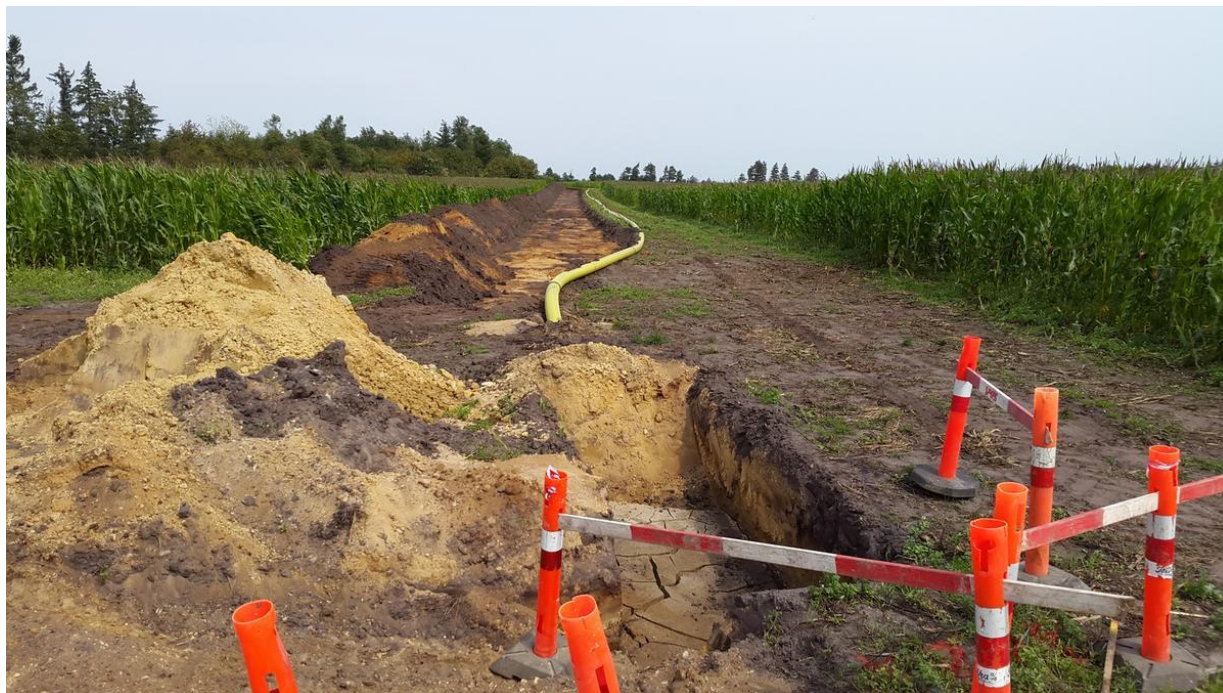
Figur 2: eksempel på anlæggelse af gasledning i rørgrav. Boregrube til underboring ses nederst i billedet.
