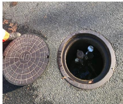
Figur 3-1 Dieselstander anlæg samt dæksel med påfyldestuds /1/
