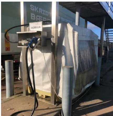
Figur 3-1 Dieselstander anlæg samt dæksel med påfyldestuds /1/
