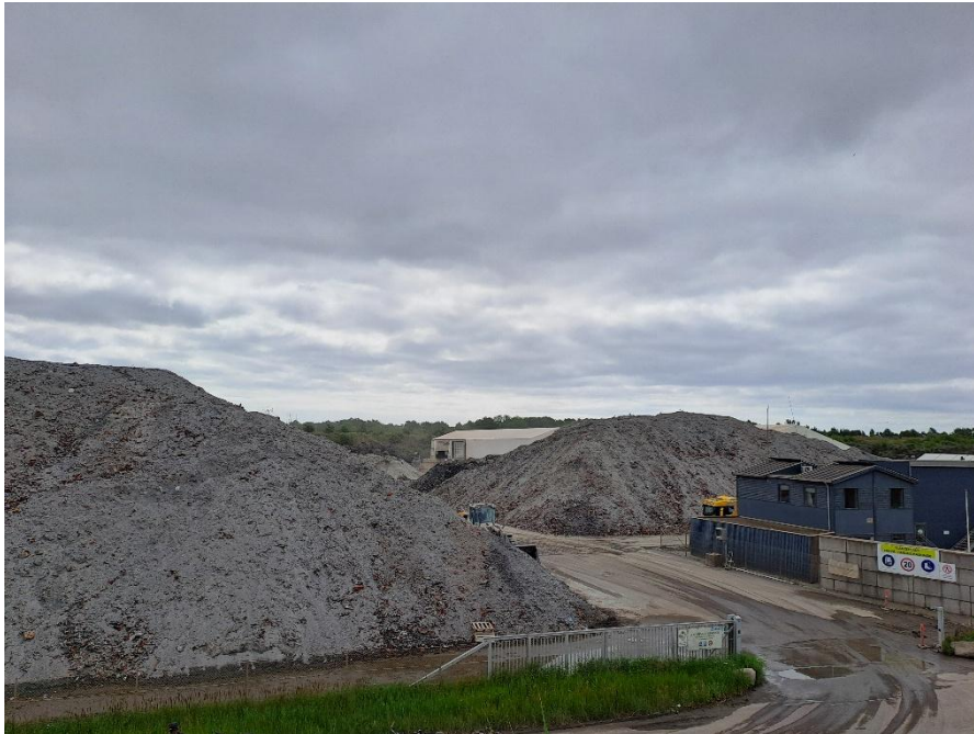
Bunker. Foto taget på toppen af volden vest for AFATEK.
