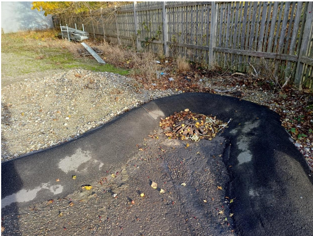
Foto 6. Afløb fra pladsen med opkant
