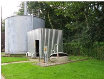
Figur 4: Gammel gaslagertank på 200 m 3 , gashytte samt kondensatbrønd.
