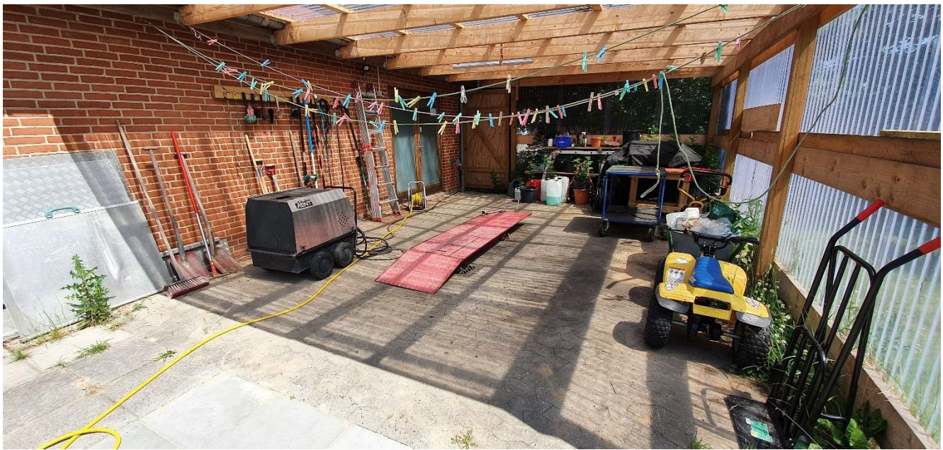
Overdækket vaskeplads med sf-stensbelægning.
