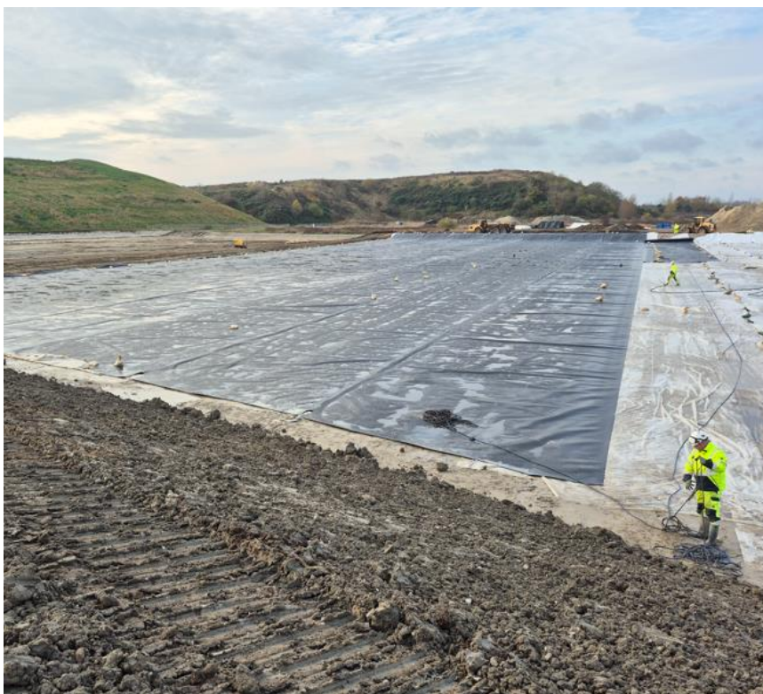
Billed 2. I den anden ende af membranen er man ved at sætte et reb i, så en maskine kan trække membranen ud.
