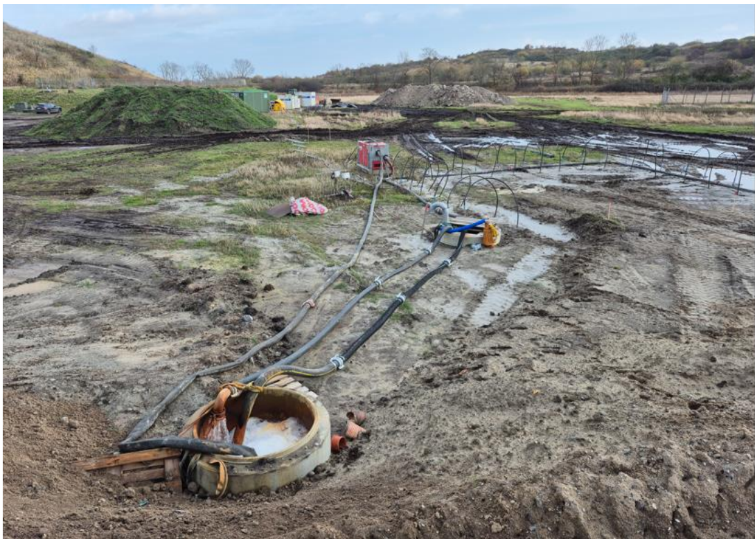
Billed 4. Sugespidsanlæg bagerst til højre og pumpebrønde til oppumpning af grundvand.
