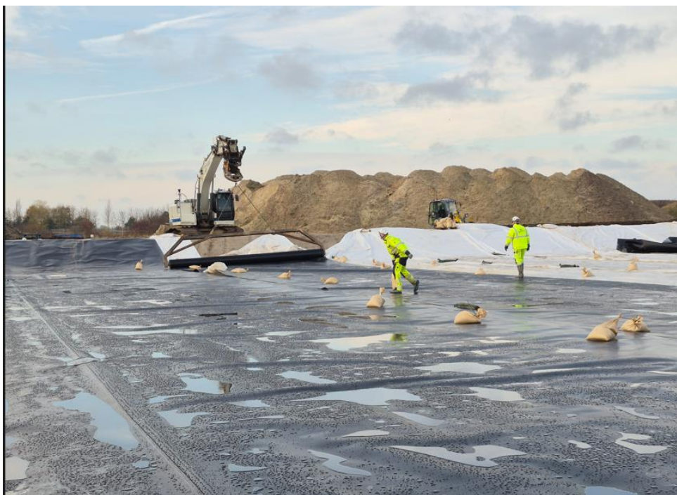
Billed 1. Membranbanen er ved at blive rullet ud. Sandsække holder membranen nede.
