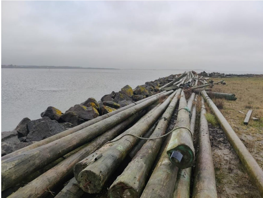
Figur 3. Oplag af pæle langs den vestlige dæmning af etape 1.
