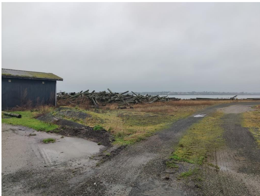
Figur 2 Oplag af pæle langs det vestlige dige. En del af bunken ser ud til at ligge på deponiets areal.
