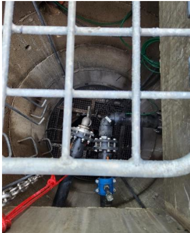
Foto 3: Det indre af perkolatbrønden på deponerings enhed 2. Perkolat pumpes op i bunden af brønden og ledes via det lodrette rør i højre side til en anden brønd, hvori der sidder en flowmåler og hvorfra der prøvetages.
