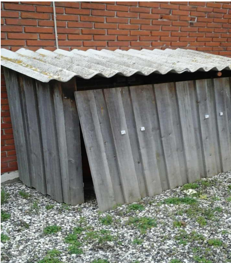
Kompressor placeret udendørs, men i foret kasse.
