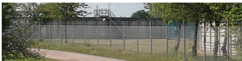
Foto1: Forrenseanlægget set fra enhed 5a.
