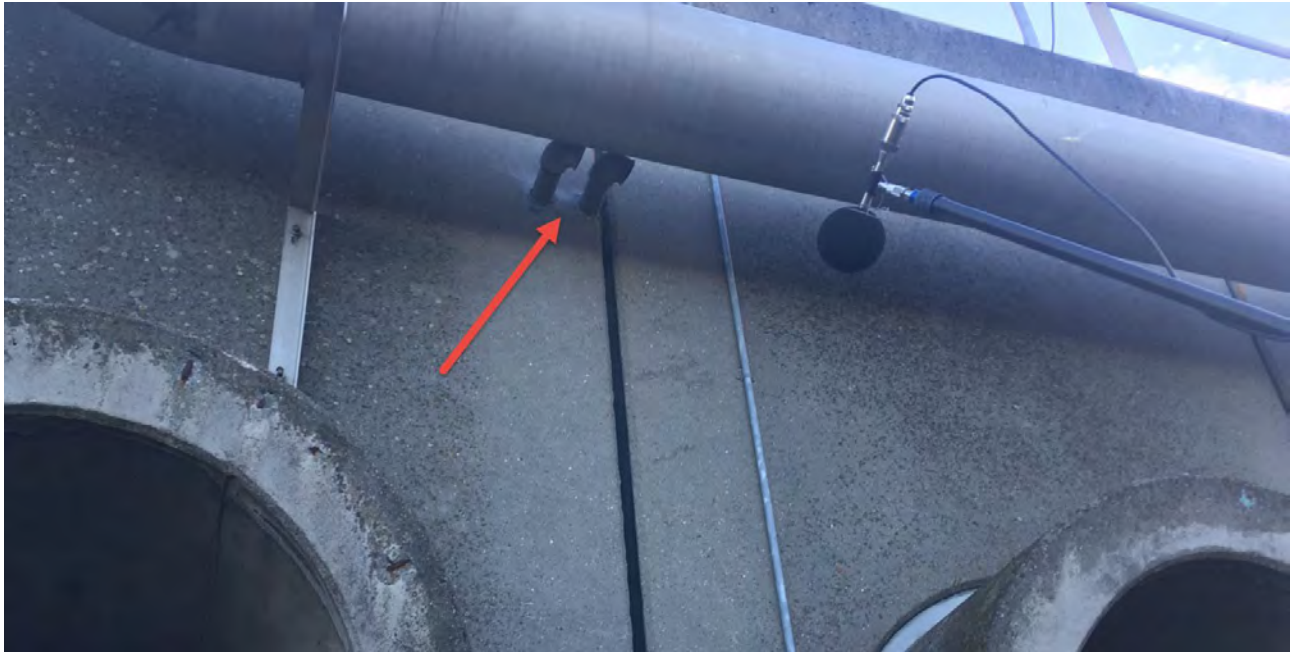
22 Polymerbygning, 2 stk. afkast via rør, imod vest, dæmpes 10 dB.
