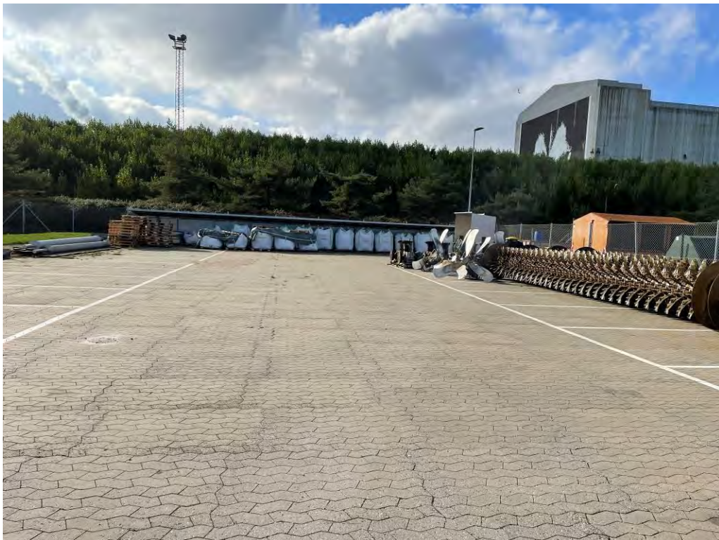
Foto 8: Midlertidigt oplagsområde af røggasaffald som stammer fra slamforbrændingsanlæg. Røggasaffaldet er midlertidig opbevaret i big bags under halvtag på SF-sten.
