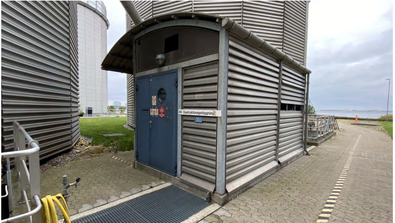
49 Gastrykforøger station, påsætning af louvre foran alle åbninger.
