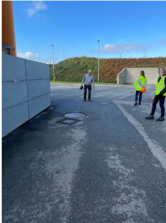
Foto 3: Olieudskiller tilsluttet til værksted kloaksystem (slamforbrændingsanlæg).
