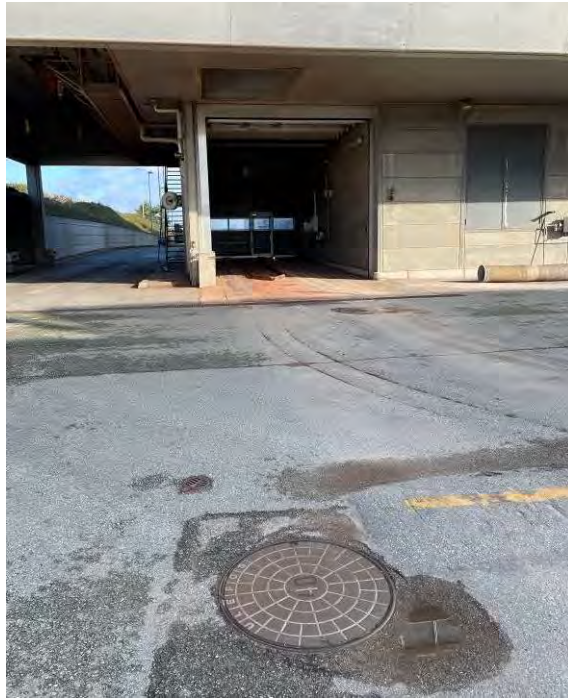
Foto 5: Området øverst til venstre anvendes til at læsse silobilerne med aske eller røggasaffald, der skal sendes til nyttiggørelse. Området øverst i midten af billedet anvendes til at læsse lastbiler med aske til deponering på askedepotet (slamforbrændingsanlæg)
