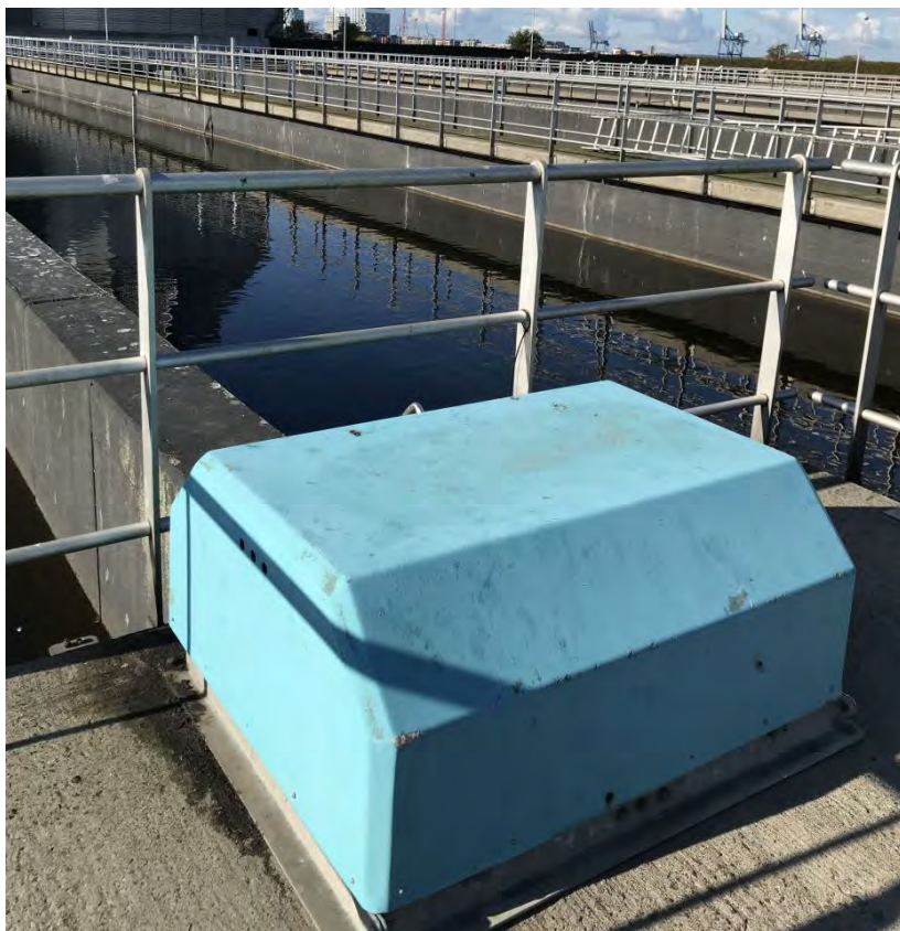
7 Sekundærtanke, motor til kædetræk, ekstra indkapsling.
