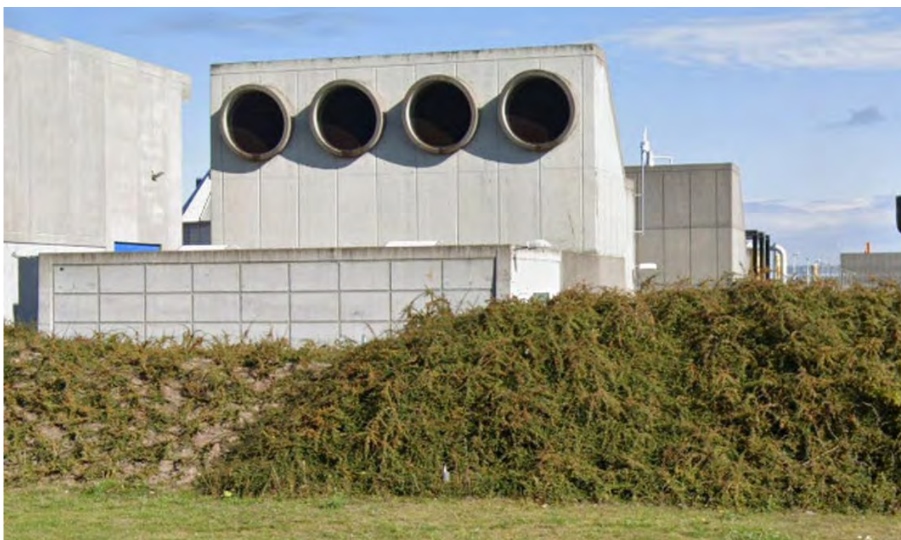
24 Transformatorstation, 4 afkast mod syd.
