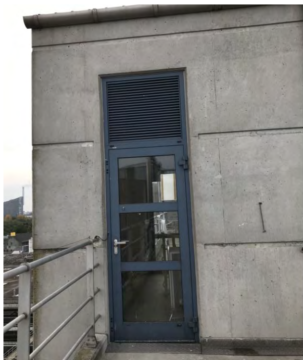
45 Rådnettanke, ventilationsrist over dør, lydæmper isættes.
