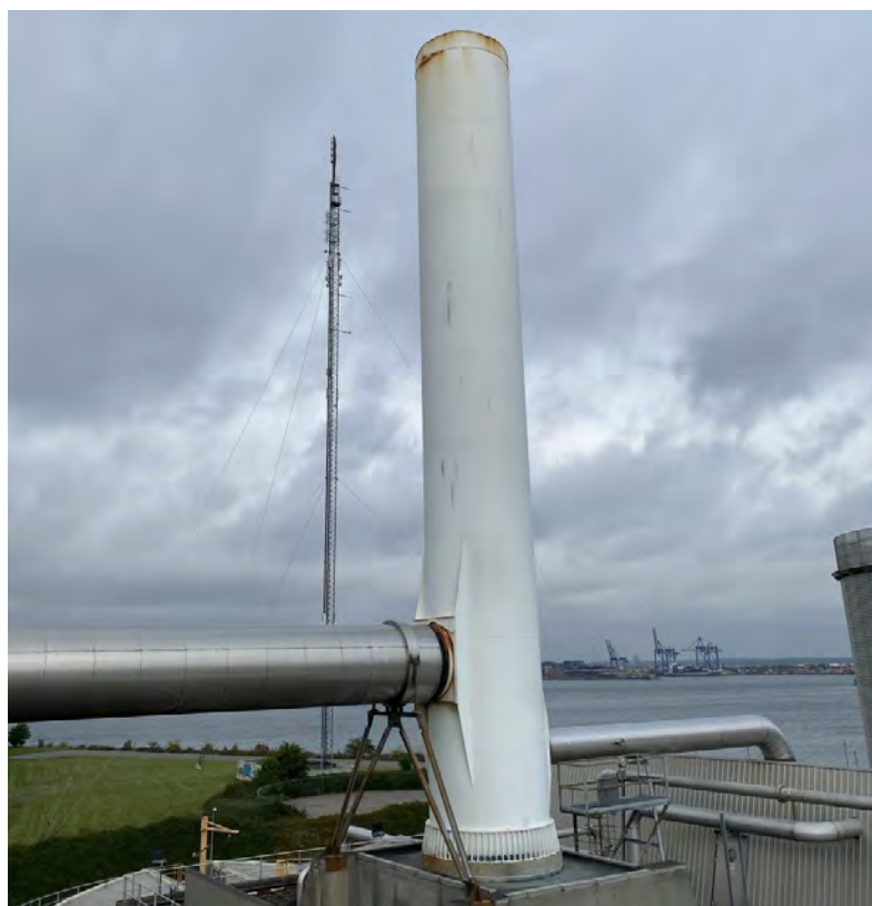
22 Polymerbygning hvid skorsten, rund lydæmper på tilgang th. eller nedsækning af cigarlydæmper.
