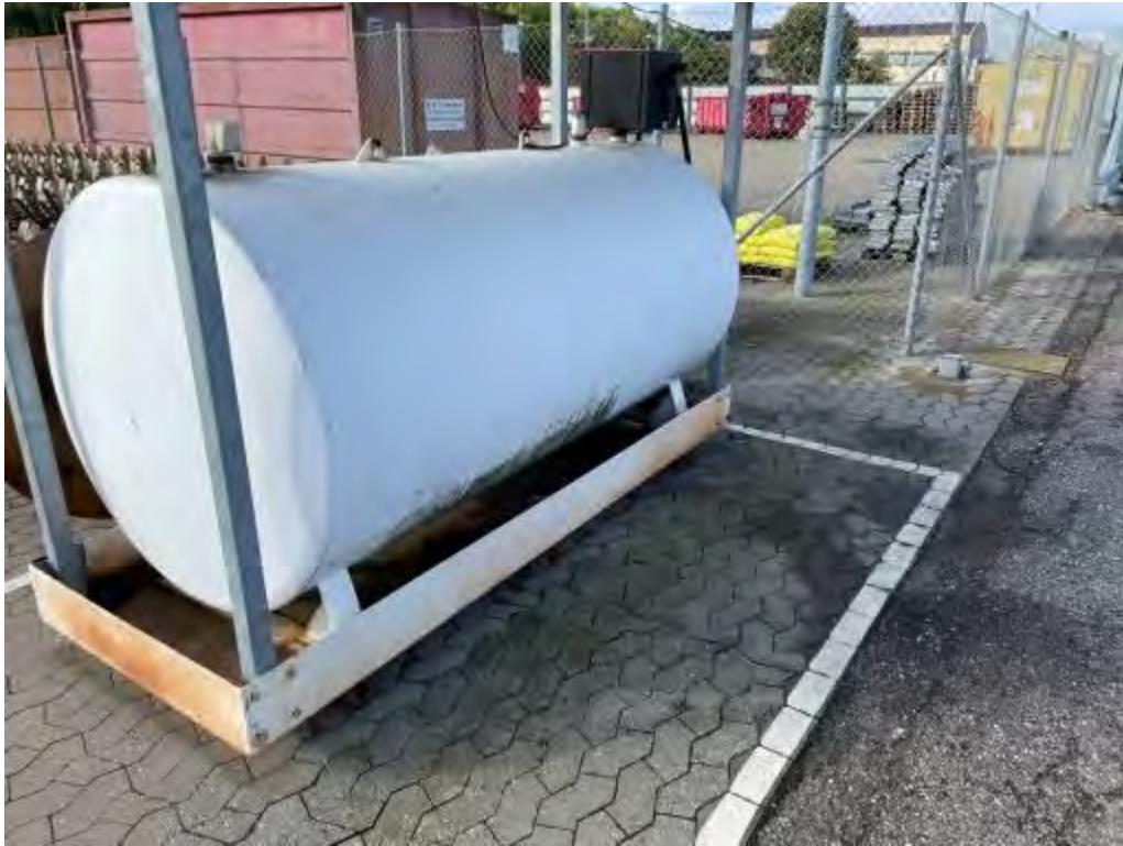
Foto 9: Overjordisk dieseltank (T2) placeret ved midlertidigt oplagsområde af røggasaffald. Placeret i spildbakke med overdækning. Dieselolie bruges til påfyldning af diverse køretøjer.
