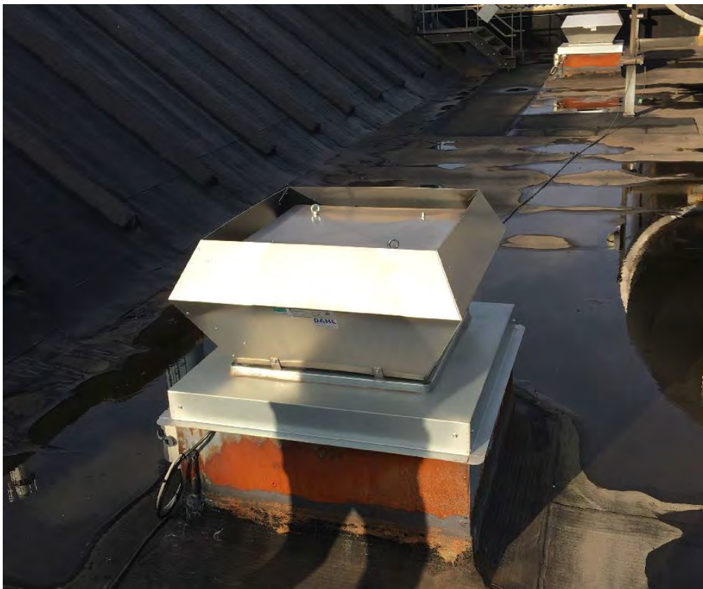
10 Slamafvanding, afkast med motor på tag (firkantet).
