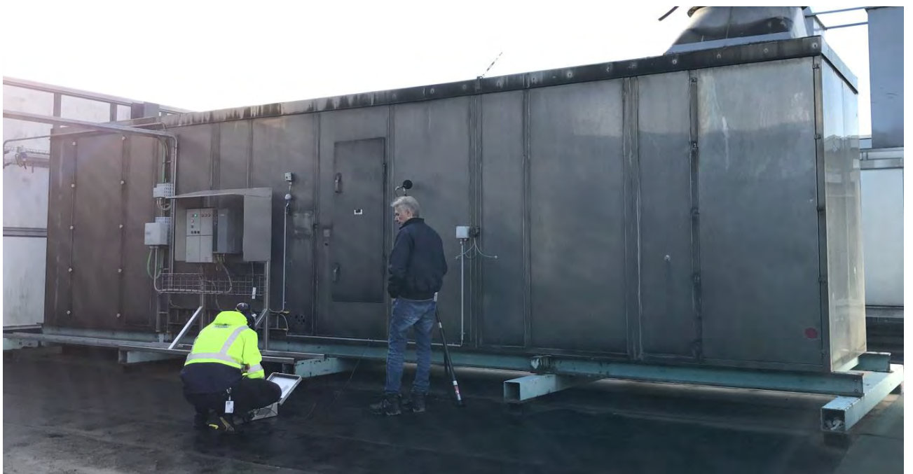
11 Slamafbrænding, bullerhus, dæmpes 5 dB ekstra.
