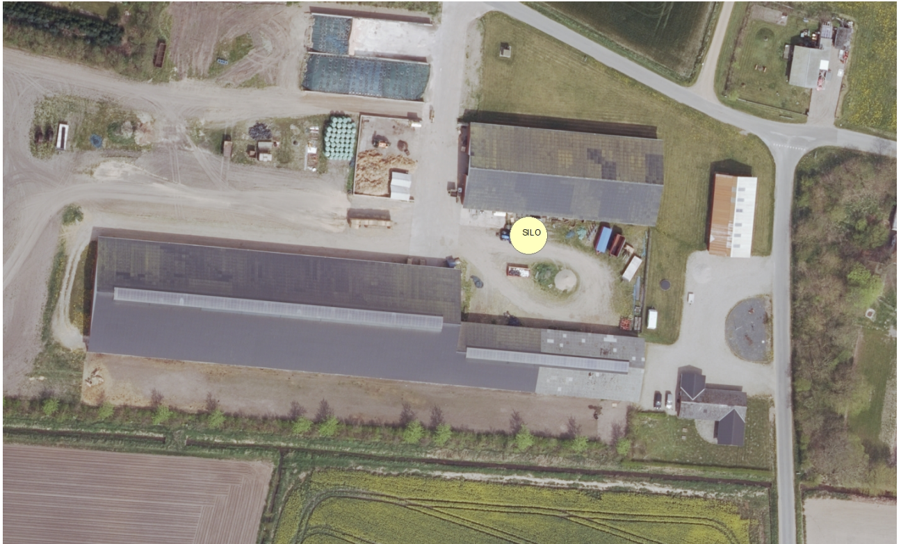
Kort 1: Oversigt over siloen og eksisterende bygninger.
