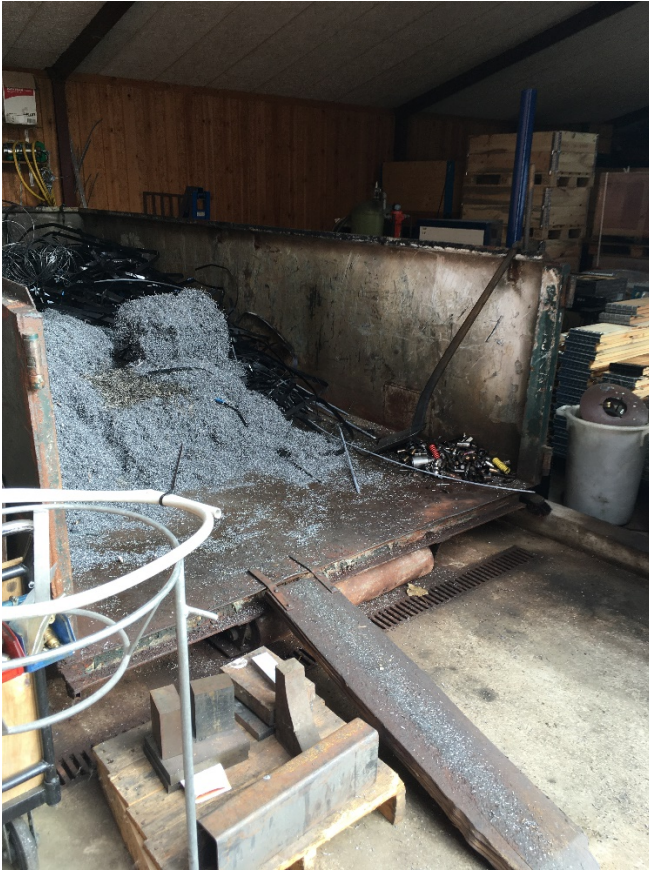
Container til jernaffald i rum med afledning til opsamlingsstank.
