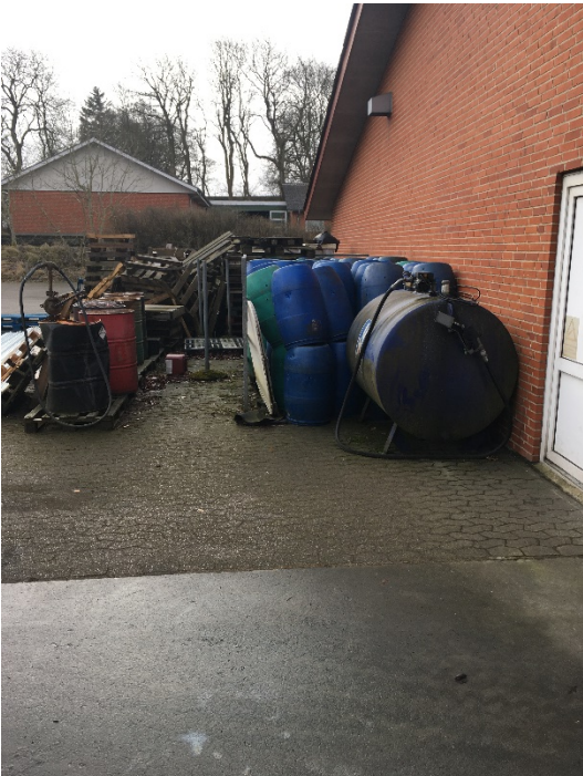
Olietank til tankning af truck og varebil, på ikke-tæt betonstensbelægning.
