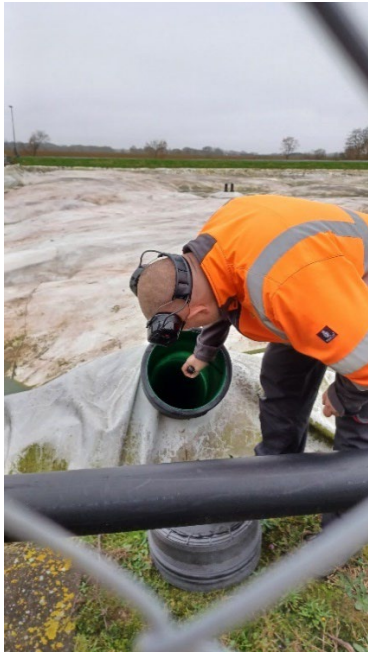
Foto 2. Demonstration af kontrol af membrantæthed i dobbeltvægede laguner som den udføres ved ugentlig miljørundring. Her ved overdækket lagune med protamylasse.
