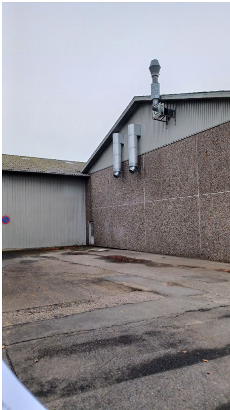
Foto 5. Installeret støjdæmpning.
