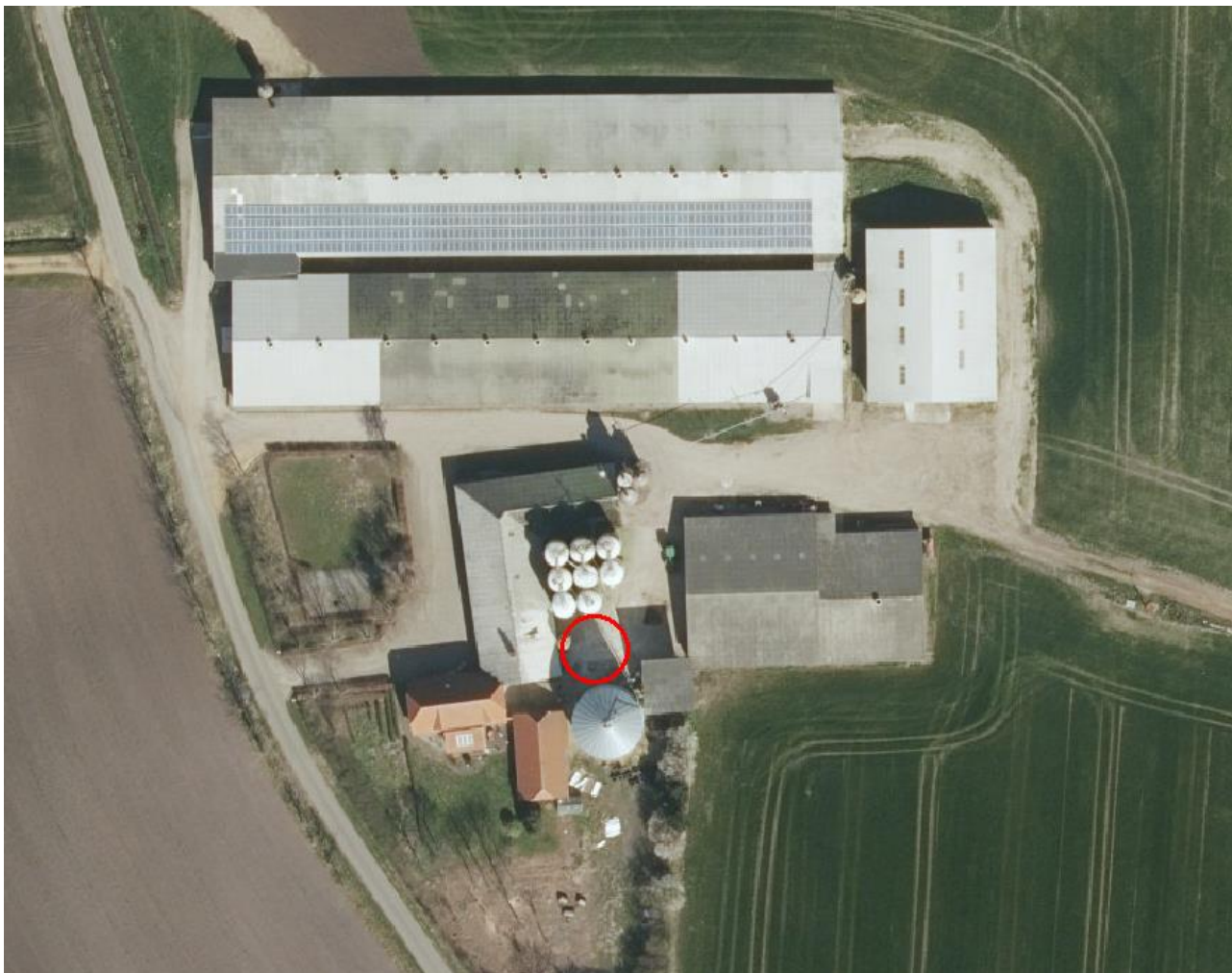
Kort 1: Oversigt over siloen og eksisterende bygninger.
