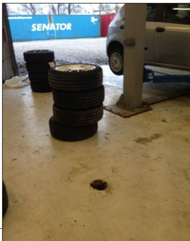
Afløb i værkstedshallen lå skjult af en dæksøjle.
