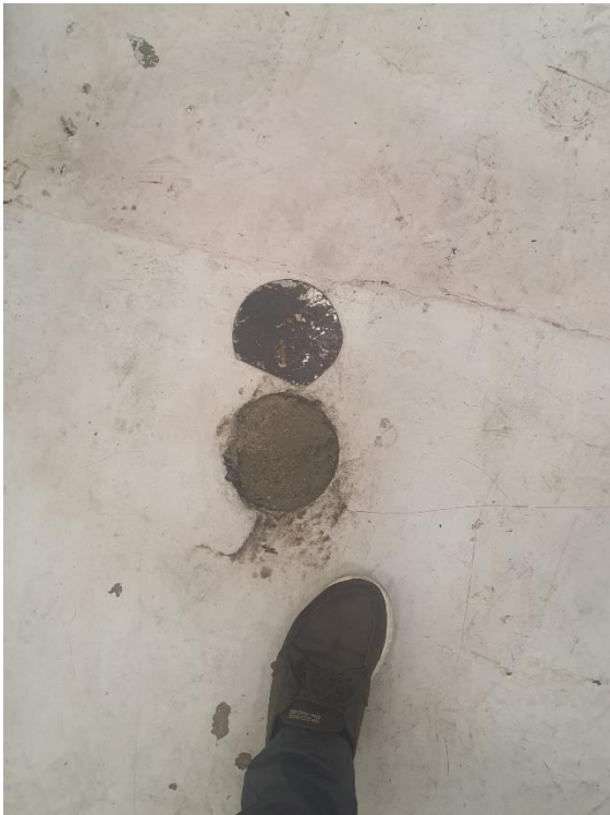
Billeder af de nu to sløjfede gulv afløb.
