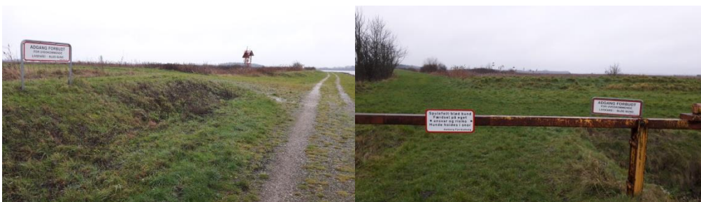
Foto 4. Deponiets indkørsel fra vest (til venstre) og fra nord (til højre) med tydelige advarselsskilte.
