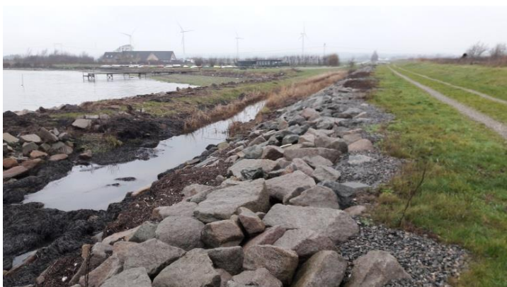
Foto 6. Deponiets afgrænsning mod Limfjorden med stenfæstning.
