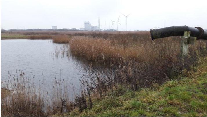
Foto 3. Udløb af fastetableret rør til indspuling af sediment til landfelt.
