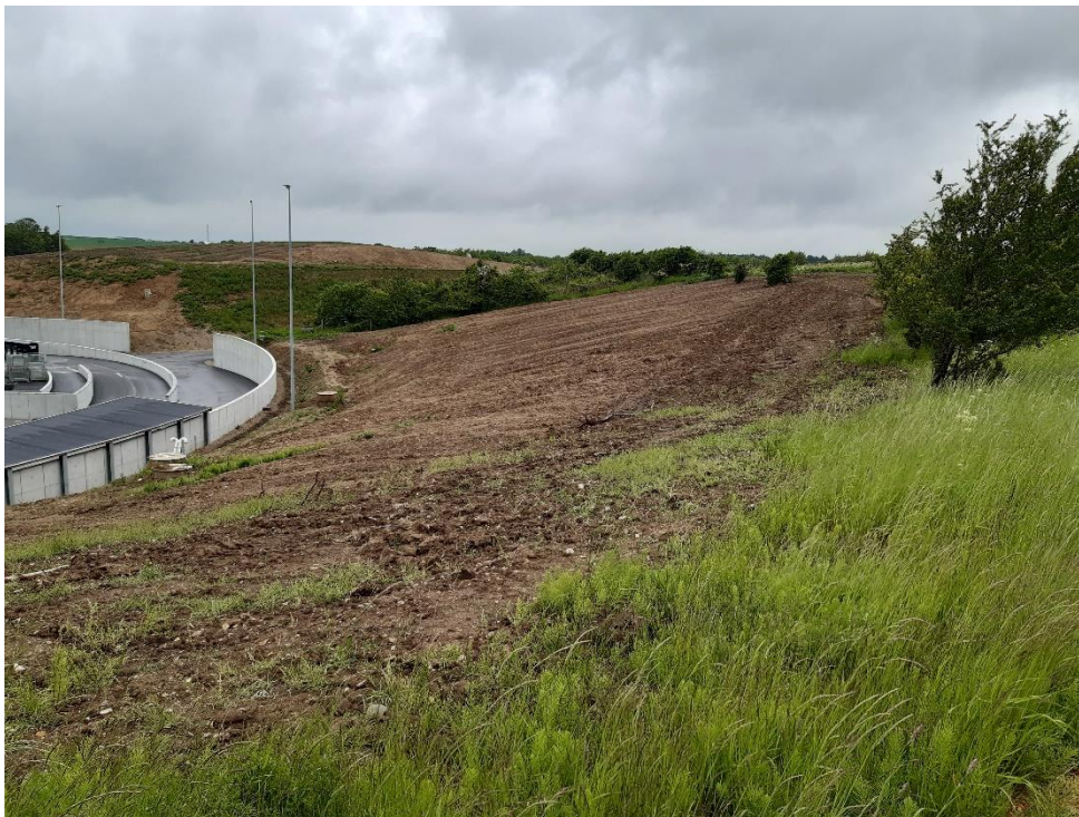
Jordopfyldning langs kanten af slaggedepot.
