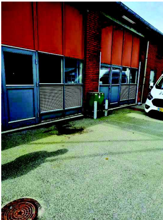
15. Luftindtag, rist A til dampkeddel
