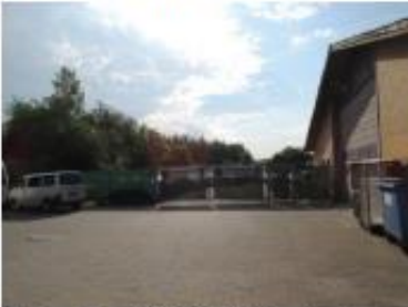
Foto 3. Eneste indkik til det udendørs oplag fra offentlig vej er ved indkørslen til virksomheden. Bemærk til venstre i billedet bevoksning v. nabo Østervej 18
