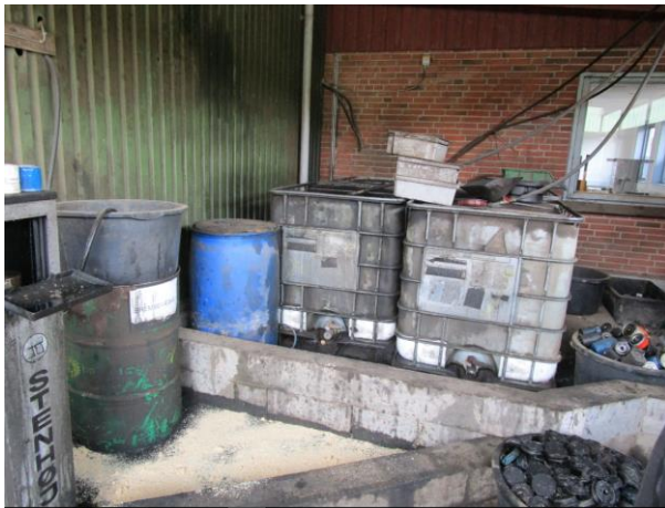
Figur 5 Affaldsrum med opkant og under halvtag. Opbevaring af sprinklervæske, kølervæske, samt oliefiltre. der spildolie mv.
