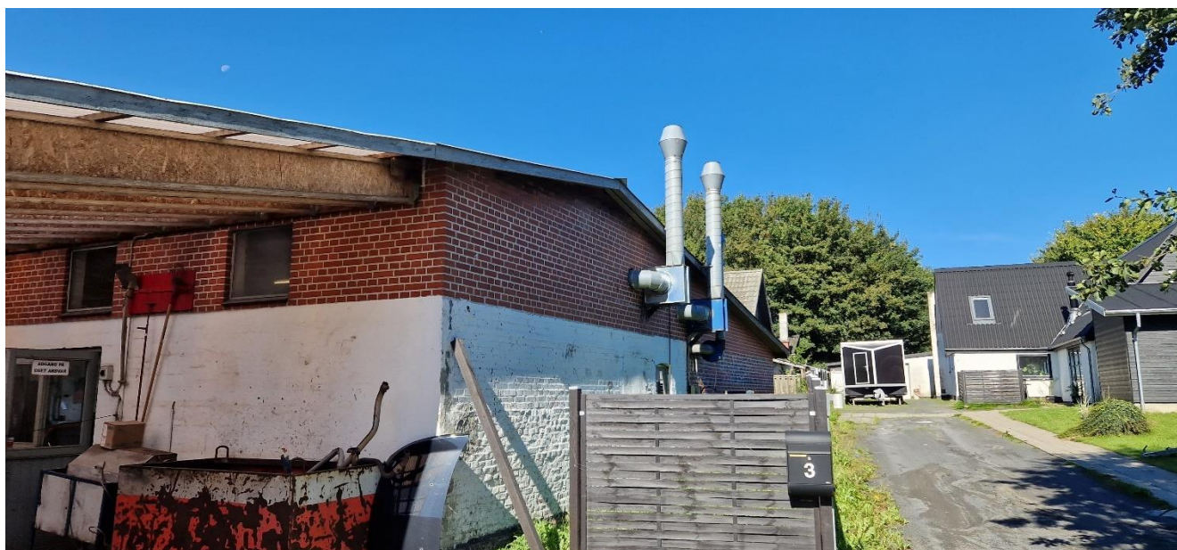
Værkstedets udsugningsafkast er ført op over tag til fri fortynding.
