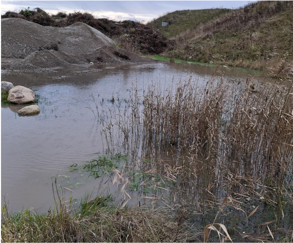
Figur 3: Oversvømmet område på anlægget
