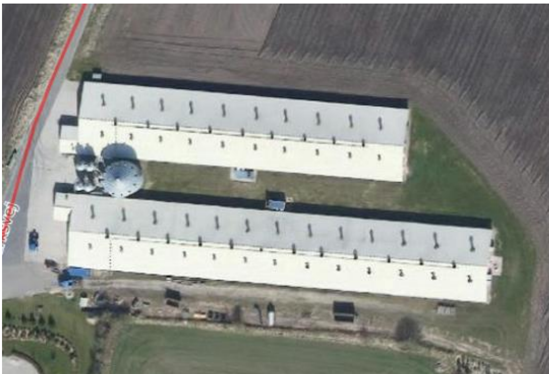
Figur 1. Oversigt over bygninger.
