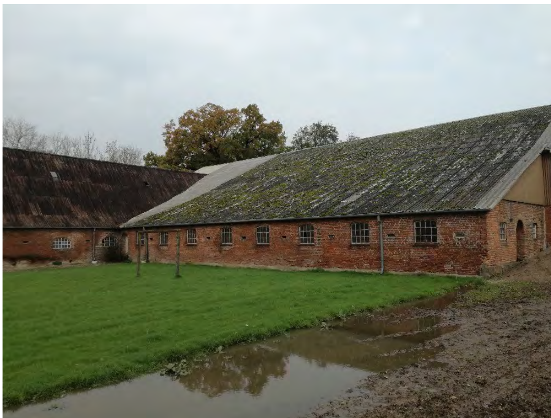
Fig. 5 Eksisterende stald/ladebygning, set fra gårdspladsen. Denne bygning erstattes.
