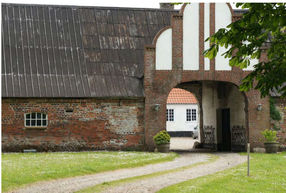
Fig. 7 Port gennemkørsel mellem gårdsplads og slotsruin, set fra vest.
