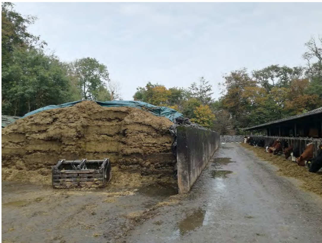
Fig. 6 Eksisterende plansilo set fra sydøst. Denne bygning erstattes.
