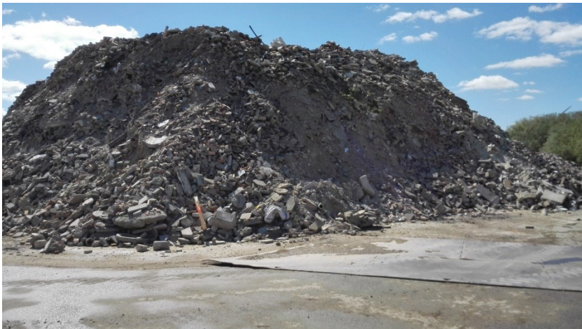
Stort læs bygningsaffald til nedknusning
